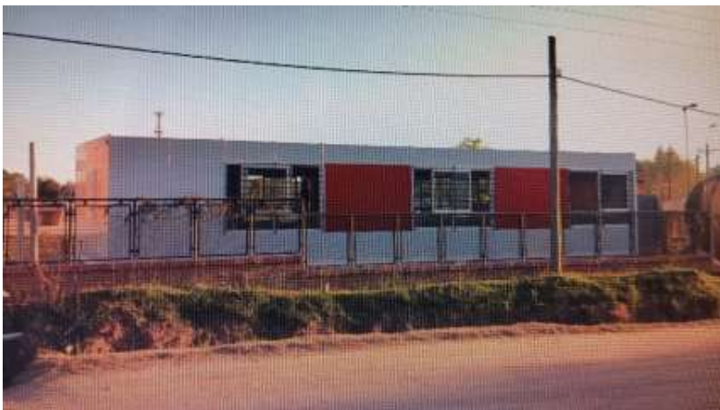
Imágenes de aula-comedor en obra (aún no está instalado el alero)
