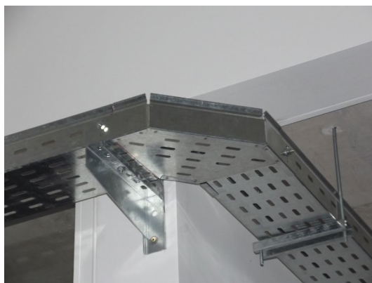
Figura 2: Bandeja con desvío horizontal
