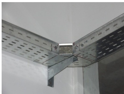
Figura 1: Bandeja con desvío horizontal
