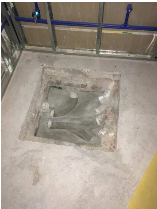
Foto 13 Cámara de inspección en L4 a terminar
