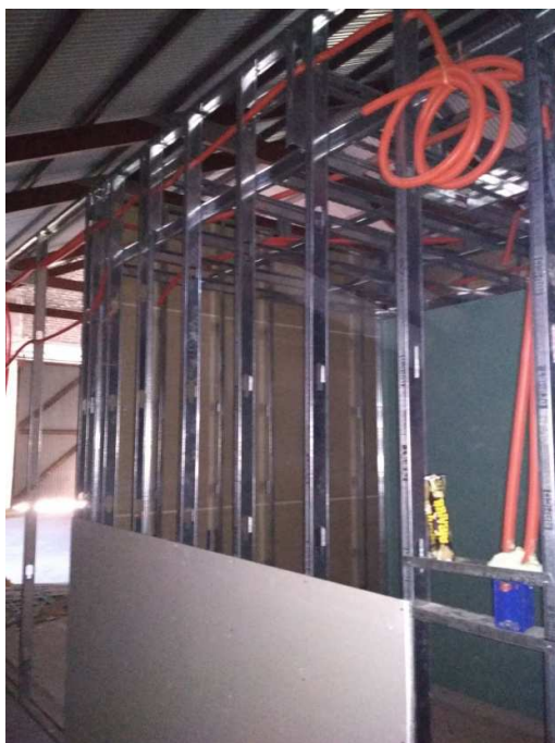
Foto 17, 18 y 19 Tabique entre L7 y L8 a terminar
