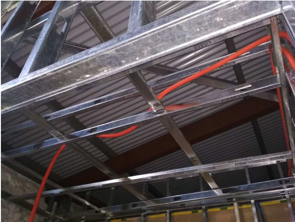
Foto 12 Estructura para cielorraso del L4
